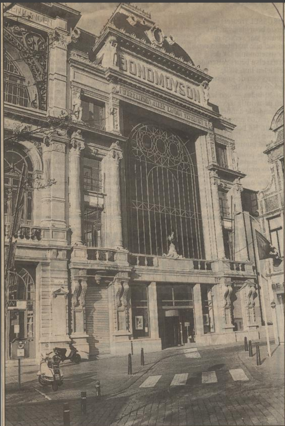
Het grote raam in de voorgevel is het orgelpunt van de renovatie.
